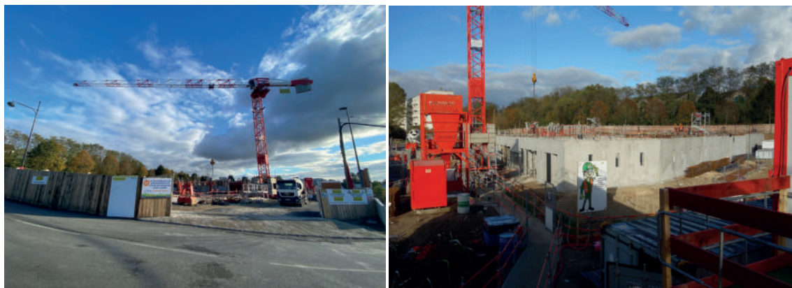
Saint Lazare : Chantier en cours ©Pays de Meaux Habitat
